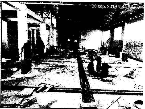
Foto N° 33 y 34: Vista de los Trabajos realizados en Area de de comercialización, construccion de muretes, y zocalo de porcelanato.
