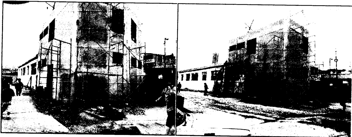
Foto N° 23 y 24: Vista de los Trabajos realizados en area de Administracion, tarrajeo de areas exteriores.
