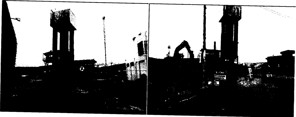
Foto N° 13 y 14: Vista de los Trabajos realizados en area de tanque elevado y grifo, demolicion de los mismos.
