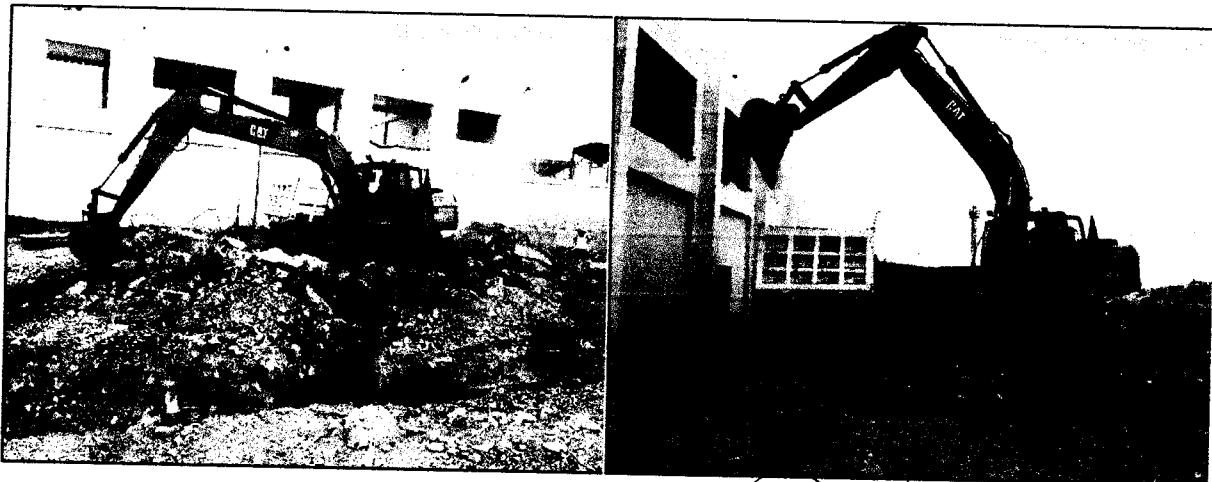
Foto N° 17 y 18: Vista de los Trabajos realizados en area de tanque elevado y grifo, eliminacion de demolicion.
